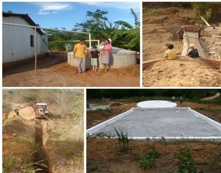
FIGURA 1. Sistemas de captação de água das chuvas: cisterna de placa, barragem subterrânea e cisterna calçadão. Município de Itinga-MG.
