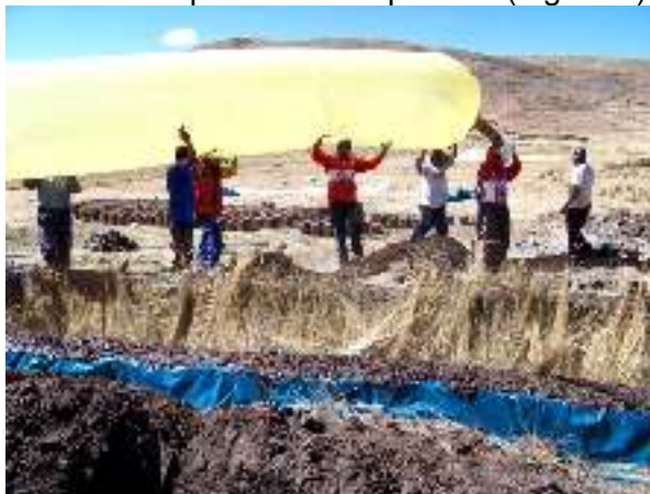
FIGURA 1. Instalando el digestor tubular en la zanja.
