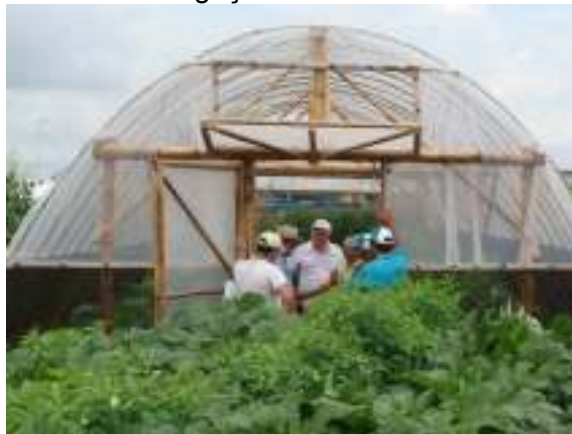
FIGURA 1. Estufa construída com bambu para cultivo de olerícolas.
