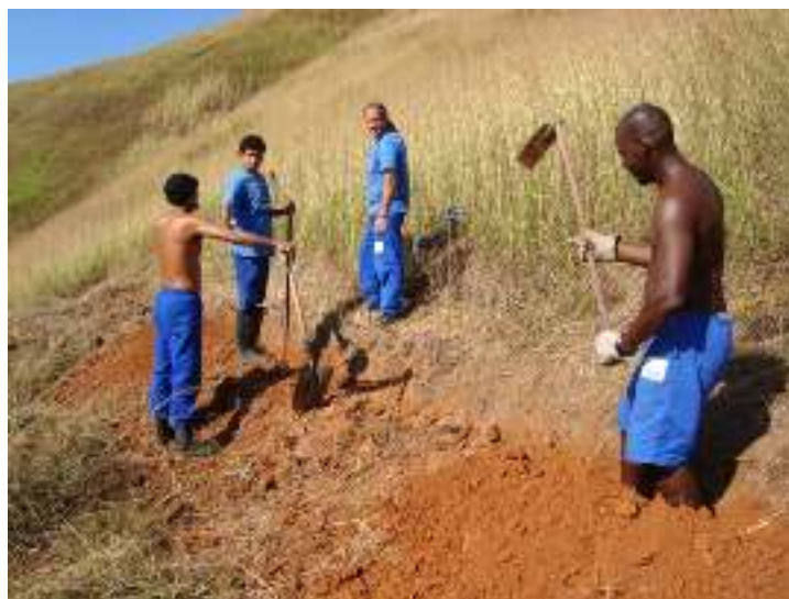
FIGURA 2. Internos trabalhando na abertura de valas em curvas em nível para minimizar os efeitos da erosão.
