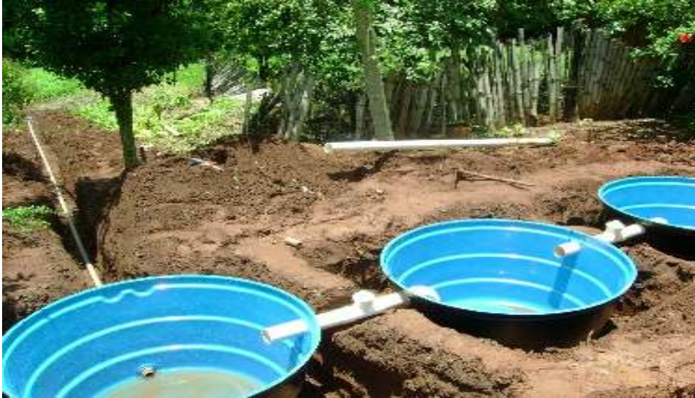
FIGURA 2. Implantação da fossa biodigestora em janeiro de 2007.
