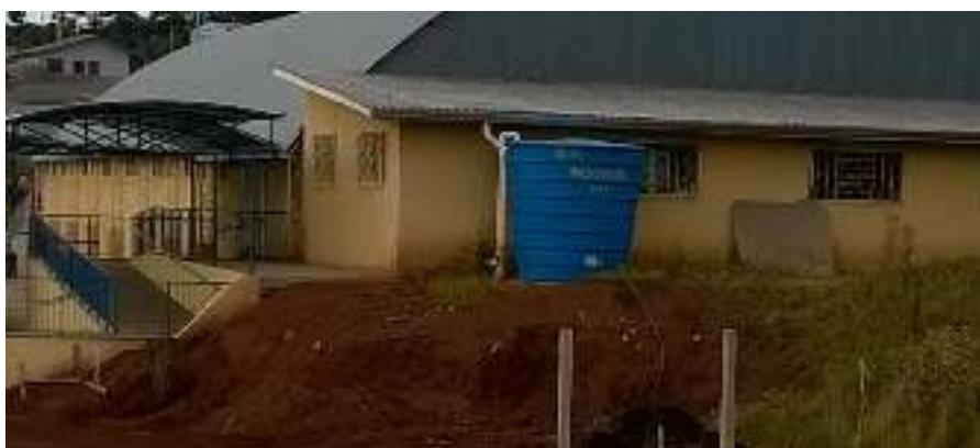
Figura 2: Sistema de captação de água
